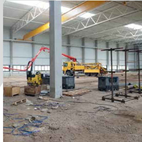
Innenansicht der neuen Produktionshalle
