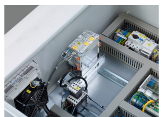
Frequenzumrichter mit ATEX Parametersatz
